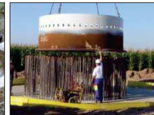
2 - Installation du système d'ancrage
