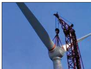
13 - Fixation du rotor (1)
