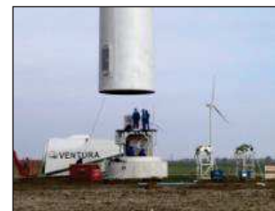
4 - Installation du 1 er tronçon
