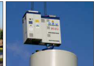
3 - Mise en place des armoires de contrôle et de commandes
