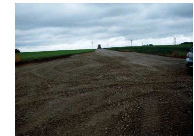
Chemin de chantier
