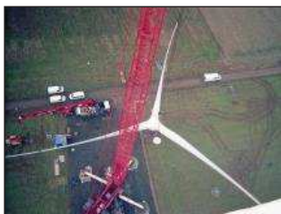
10 - Assemblage des 3 pales
