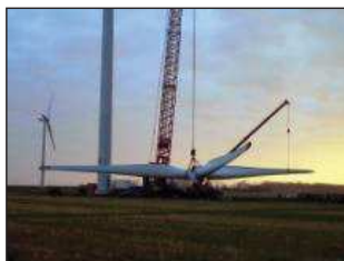
11 - Levage du rotor (1)
