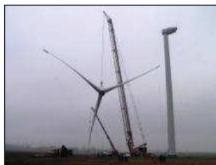
12 - Levage du rotor (2)
