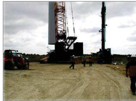
Figure 88 : Photo d'une plateforme de montage (Source : EDPR)
