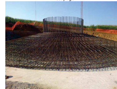
Mise en place de l'armature métallique
