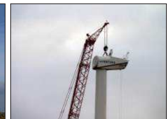
6 - Pose de la nacelle
