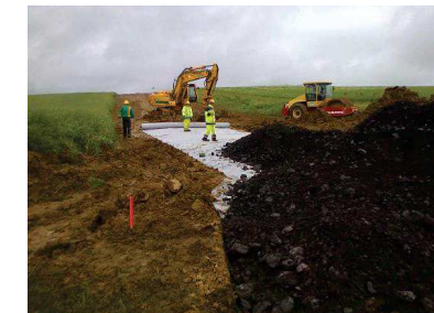
Pose d'un géotextile
