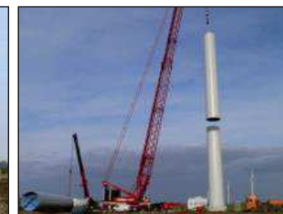
5 - Installation du 2 ème tronçon
