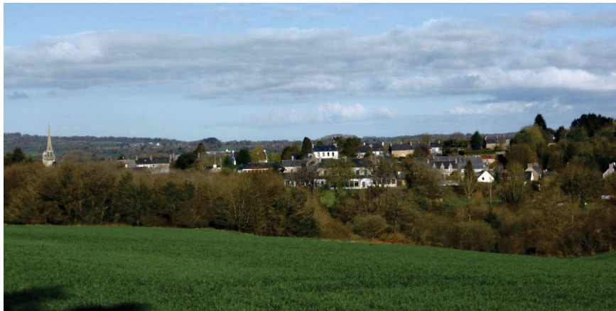
La plupart des habitations du centre-bourg de Pont-Melvez sont orientées vers le sud-est
