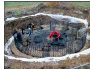
1 - Ferrailage de la fondation
